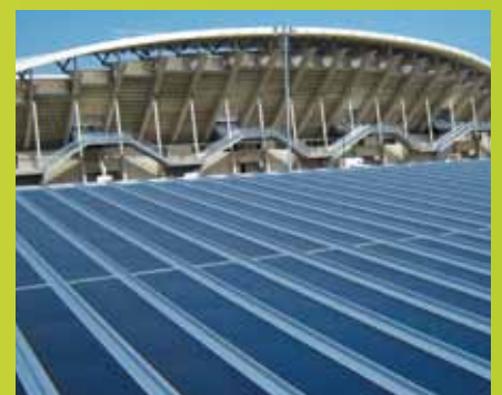
Le stade Yves du Manoir de Montpellier Agglomération produit 28 600 kWh/an grâce à ses 380 m 2 de panneaux photovoltaïques.
