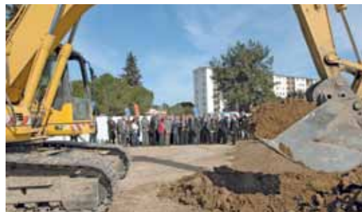
Coup d'envoi des travaux de la 3 e ligne de tramway le 19 mars sur la future avenue Massena.
