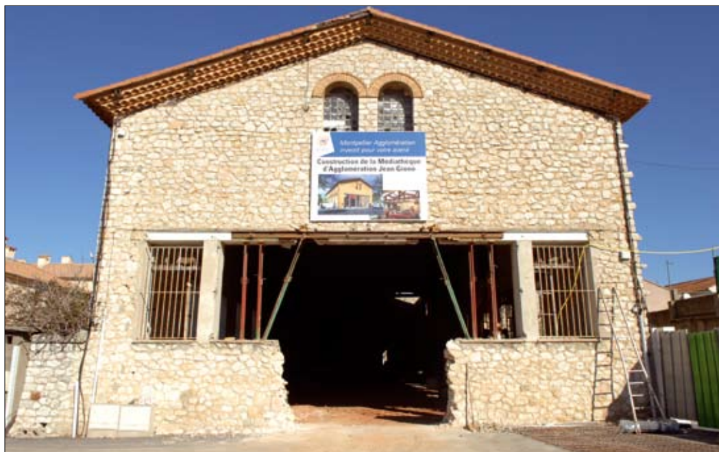
L'ancienne usine de bonnetterie sera transformée en médiathèque d'Agglomération à Pérois.
