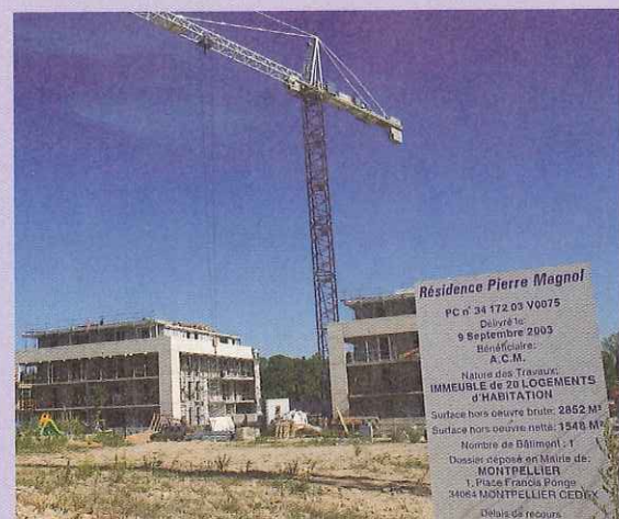
De nombreux logements sociaux sortent de terre. Ici, dans le quartier Malbosq à Montpellier.
