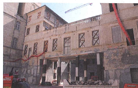
La cour Bourdon, creusée sur près de 7 m de profondeur.
