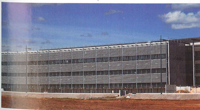
Construit sur un terrain d'un hectare, Cap Omega est un bâtiment linéaire de 90 m de long et de 5 300 m 2 sur trois niveaux.
