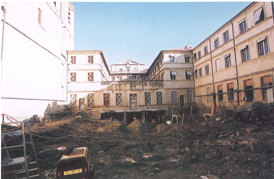
Travaux en cours au Musée Fabre. PHOTO : MONTPELLIER AGGLOMERATION
