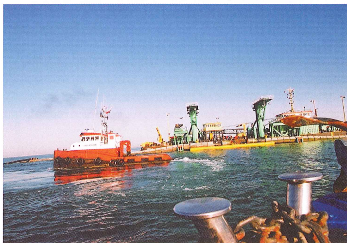
Mise en place de l'émissaire en mer.
