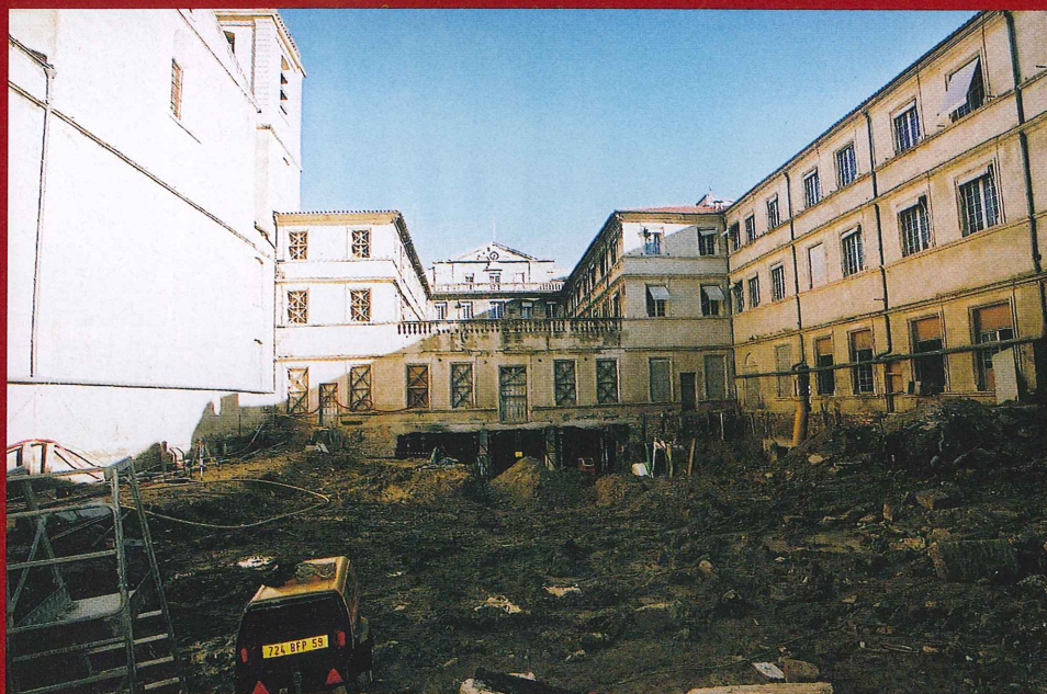
Le creusement de la cour Bazille, futur hall d'accueil du musée. PHOTO : MONTPELLIER AGGLOMÉRATION
