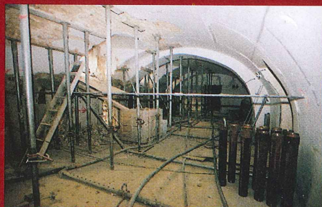
Mise à nu et restitution des salles originelles comme dans l'ancien Collège et ses voûtes en pierre.
