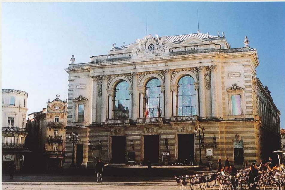
En 2003, Montpellier Agglomération a prévu un budget d'investissement de 872 021 euros pour répondre aux exigences de confort des spectateurs et aux mesures de sécurité. En 2004, les travaux de maintenance et de sécurité se poursuivent. De gros travaux, notamment la restructuration de la loge de scène, vont entraîner la fermeture de l'opéra pendant l'année 2005. PHOTO : MONTPELLIER AGGLOMERATION
