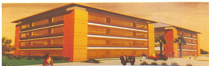
Cap Gamma : deux bâtiments jumeaux conçus par les architectes Gilles Chrétien et Jean-Luc Martineau.
